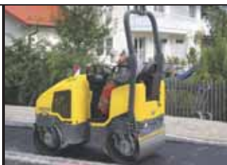
RD 16 pri asfaltérskych prácach
